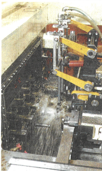
圧造部上部に設置された新PCS
